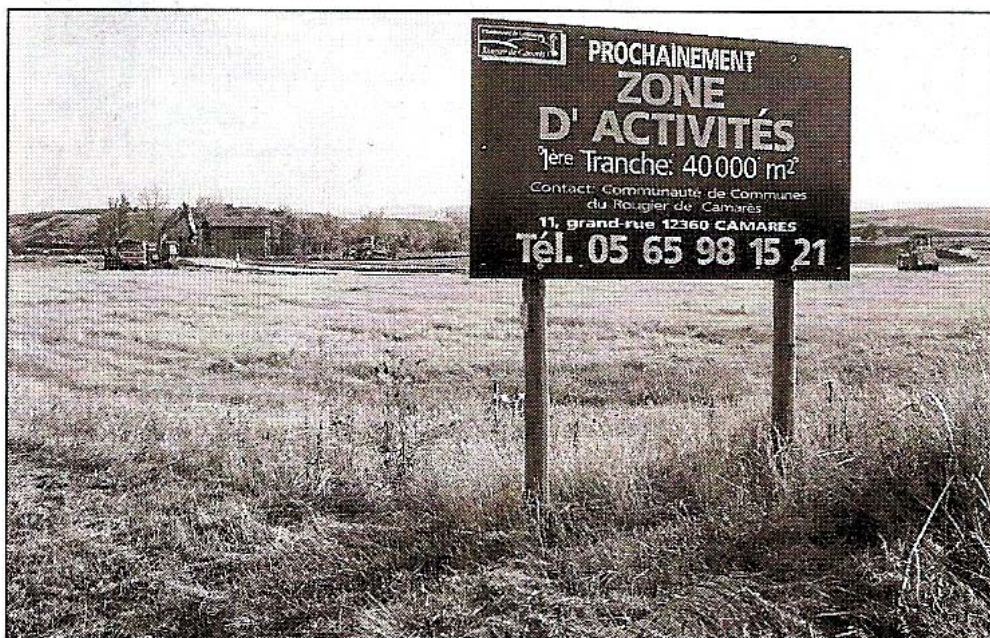
Les travaux de terrassement et d'empierrement des voies ont débuté.
