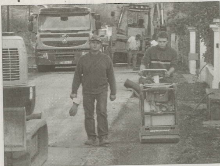
■ Les travaux avancent bien : l'élargissement de la route est terminé.
