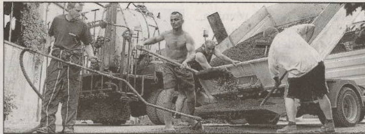
La fin des gros travaux d'enfouissement des réseaux approche.
