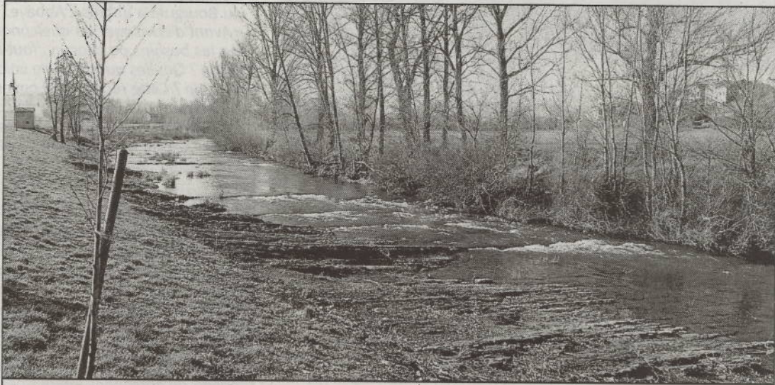
Le tronçon du Dourdou réservé à ce parcours se situera entre la chaussée du Barry et le pont submersible.
